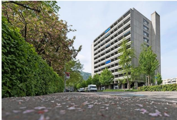
Das Haus, so hoch es auch ist, steht auf Stelzen. Wertvoll ist auch der Raster der Balkonbrüstungen. Foto: Urs Jaudas
